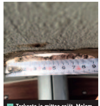
7 Tarkasta ja mittaa reiät. Molemmat olivat 9,5 cm, mikä on yleinen mitta.
