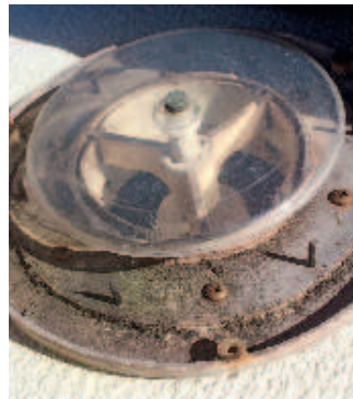
2 Vanha muovi on jo haurastunut. Poista venttiilimekanismi.
