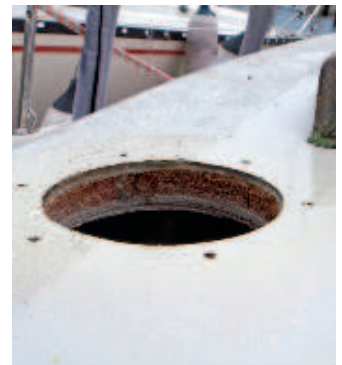
11 Puhdas kansipinta valmiina uutta venttiiliä varten.
